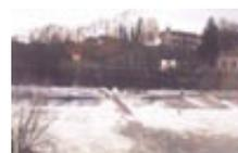
Il s'agit d'un barrage à clapets. En période de hautes eaux, les clapets de part et d'autre de la glissière sont baissés et il devient hasardeux de s'engager dans la passe.
